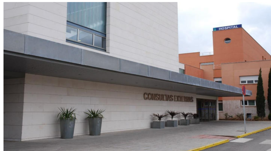
Hospital General de Valdepeñas (Ciudad Real)
