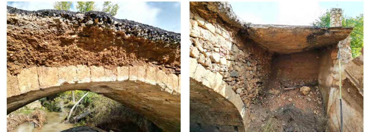
Figura 8. Detalle del relleno superior y tímpano aguas abajo del puente antiguo
