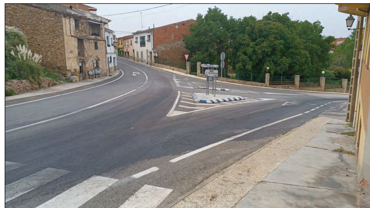
FOTO 2. Intersección de CM-215 con N-330 en Landete. Existe una pendiente pronunciada hacia la CM-215, falta de visibilidad y edificaciones muy próximas a la calzada. Vista desde N-330
