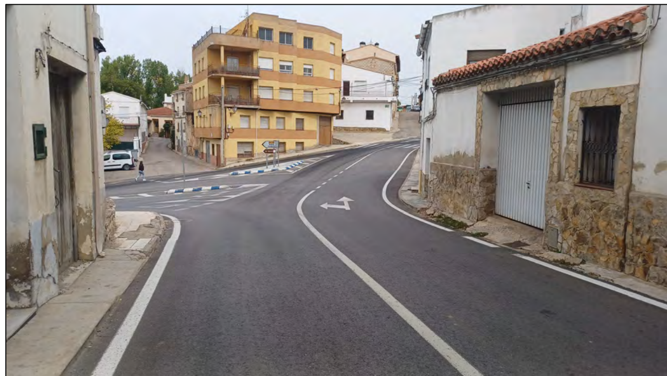
FOTO 1. Intersección de CM-215 con N-330 en Landete. Existe una pendiente pronunciada hacia la CM-215, falta de visibilidad y edificaciones muy próximas a la calzada. Vista desde N-330
