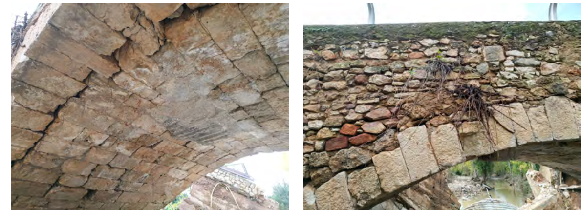
Figura 9. Detalle del paramento de aguas arriba tras el derrumbe y estado de la bóveda
