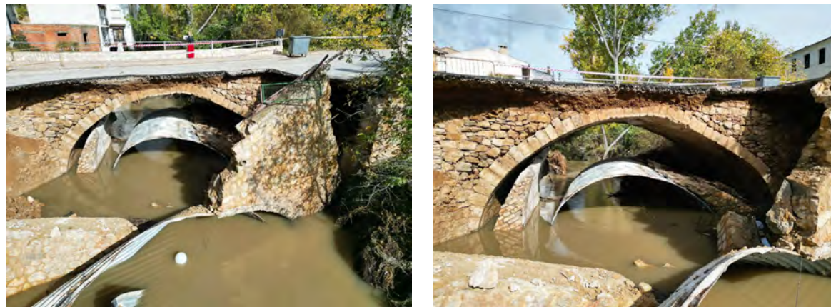
Figura 7. Estado previo al hundimiento del tramo ampliado y descamisado del antiguo
