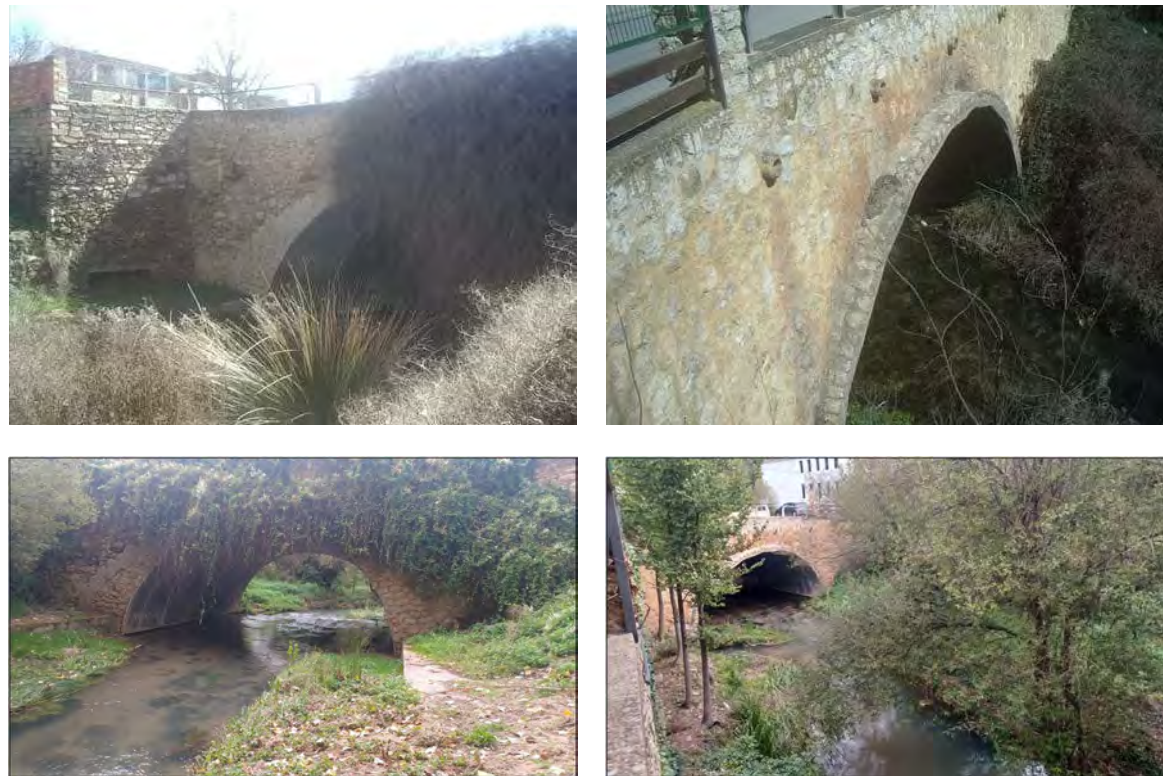
Figura 6. Estado previo al hundimiento del tramo ampliado y descamisado del antiguo
