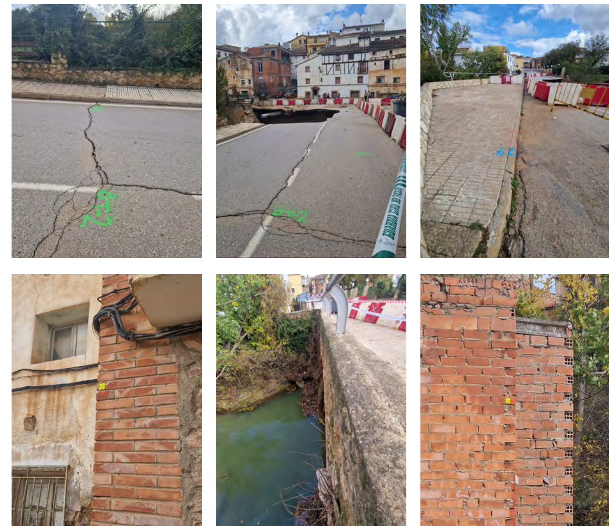
Figura 11. Puntos de control (testigos) del movimiento del puente y dianas de calibración
