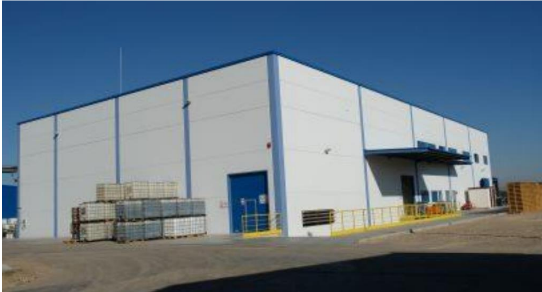
Fábrica de pinturas y masilla para la construcción de BASF en Marchamalo.
