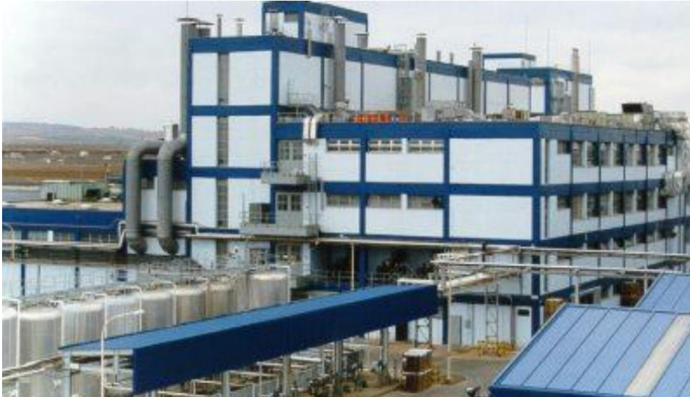
Planta de Producción de pinturas de BASF en Marchamalo.
