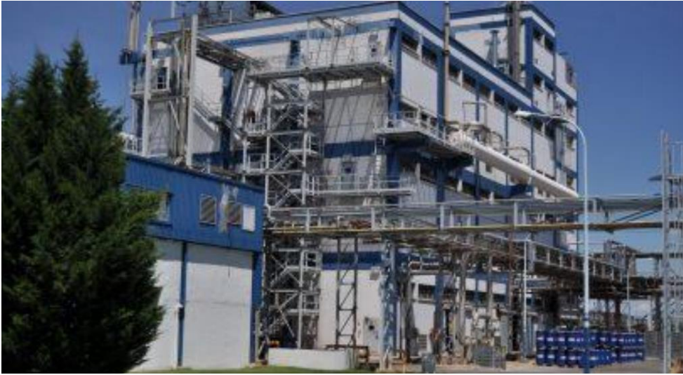
Planta de Producción de resinas de BASF en Marchamalo.
