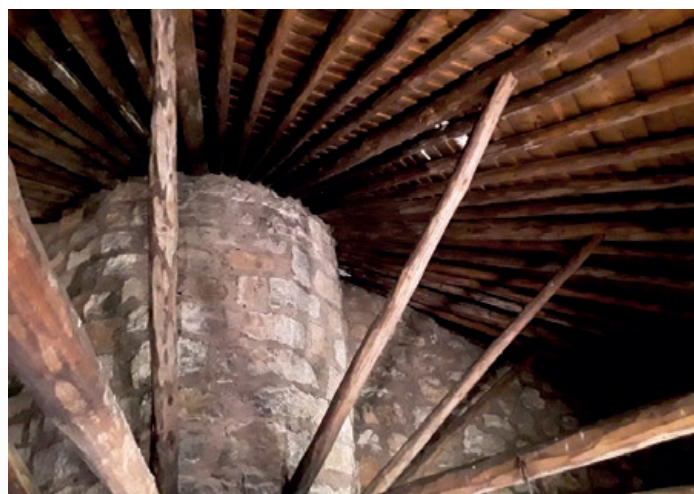
Tejado del refugio de Las Majadas, con huecos y falta de aislamiento.
