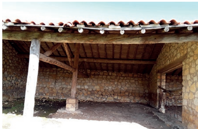
Estado actual de la cubierta del establo de Las Majadas, donde se aprecia como la viga está combada.
