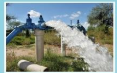
Extracción de agua
