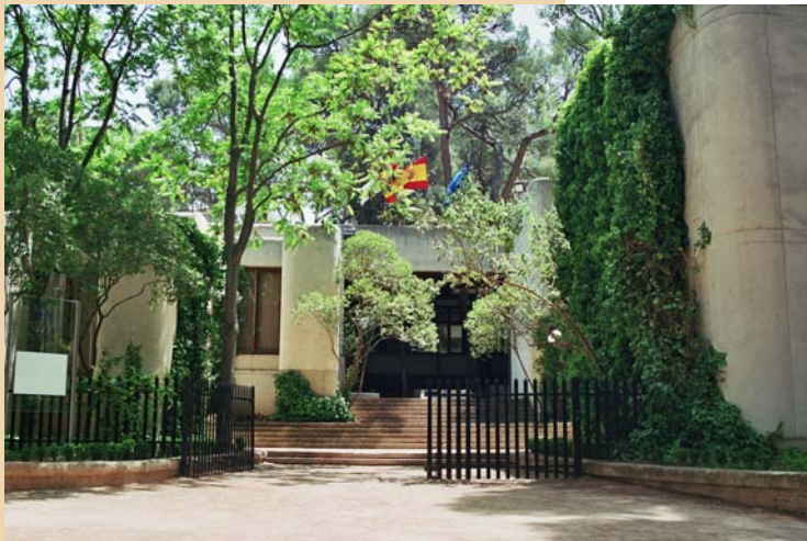
Acceso inaccesible, sólo dotado de escaleras al museo
