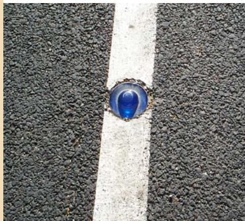
Baliza luminosa integrada en el pavimento
