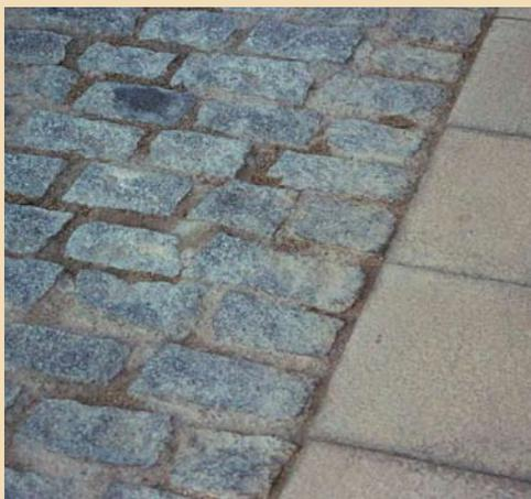
Detalle de pavimentos. Puede observarse la cuidada ejecución en la unión entre ambos. La irregularidad superficial y amplitud de llagas del adoquín hace que resulte incómodo e inconveniente. Las losas de granito son una mejor solución para cualquier paseante, y en concreto para aquellos con alguna discapacidad
