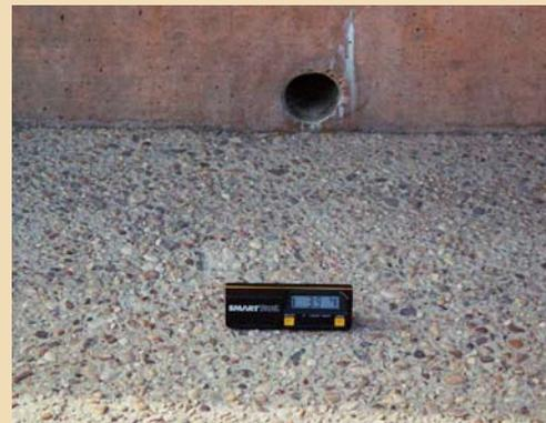
*Detalle de superficie en rampa; el clinómetro marca una pendiente del 3,9 %, muy suave*
